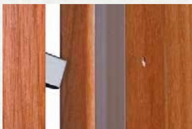
Depois da instalação da fechadura e terminada a regulagem da porta se deixa o bico de fora e se dá uma leve batida no batente. A marcação deixada pelo bico será o centro do furo.
